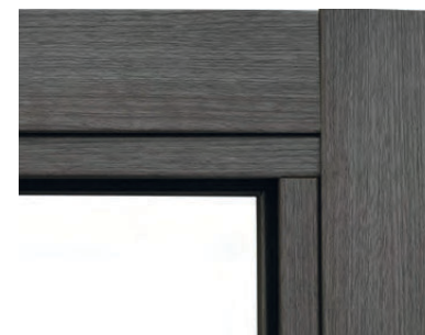
KOLMÉ NAPOJENÍ SVISLÝCH A VODOROVNÝCH ČÁSTÍ ZÁRUBNĚ
